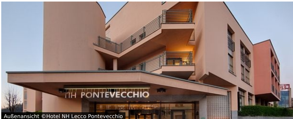
Außenansicht ©Hotel NH Lecco Pontevecchio
