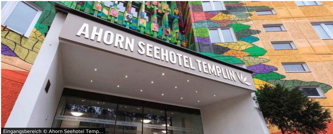
Eingangsbereich © Ahorn Seehotel Temp...
